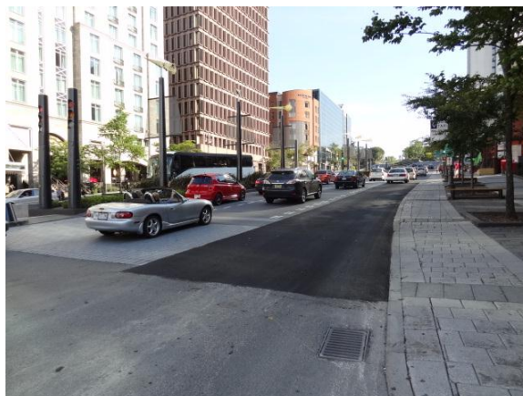
Photo 16 – Les plaques d'asphalte
