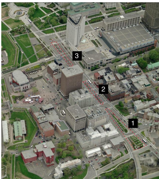
Photo 5 – Le terre-plein central
